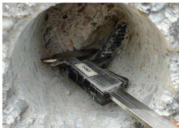
Fig.5.1 – Misurazioni dirette dei diametri e dei copriferri delle armature
